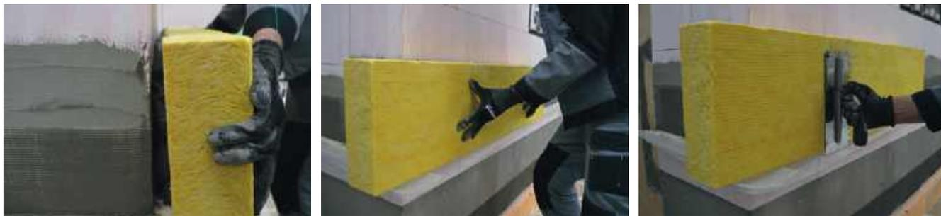
При выходе клеевой/армировочно-клеевой смеси за границы плиты теплоизоляции излишки удаляются.
