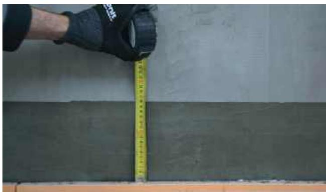
Перед созданием базового штукатурного слоя на поверхность утеплителя наносится гидроизоляционный состав тонким слоем (0,7–1 мм). Состав рекомендуется наносить при помощи кисти или кельмы.
