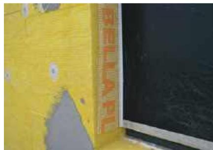
Перед нанесением армировочно-клеевой смеси поверхность теплоизоляции в районе откосов грунтуется на сдир.
