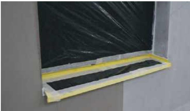
**Примечание.** Нанесение защитно-декоративного слоя рекомендуется производить не ранее чем через 24 часа после нанесения герметика.
