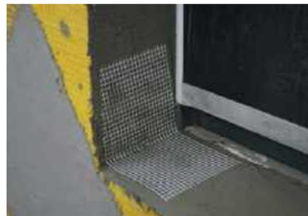
Усиливающий элемент внутреннего угла откоса утапливается в армировочно-клеевую смесь. Для исключения образования радиуса в районе внутреннего угла откоса усиливающий элемент рекомендуется продавить (с небольшим нажимом) мастерком.
