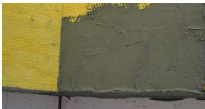
В районе внешнего угла нижней грани плиты теплоизоляции армировочно-клеевая смесь наносится с избытком, таким образом чтобы под пластиковым сердечником элемента внешнего угла с капельником не образовывалось пустот.
