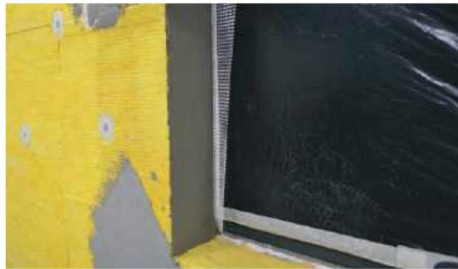
Сетка элемента примыкания утапливается в армировочно-клеевую смесь.
