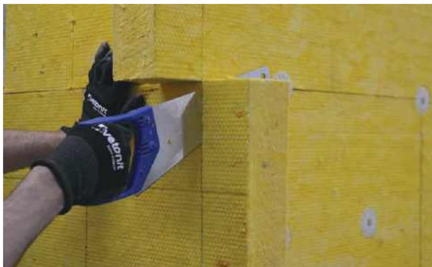
При необходимости резанные кромки плит теплоизоляции дополнительно обрабатываются при помощи абразивных терок.
