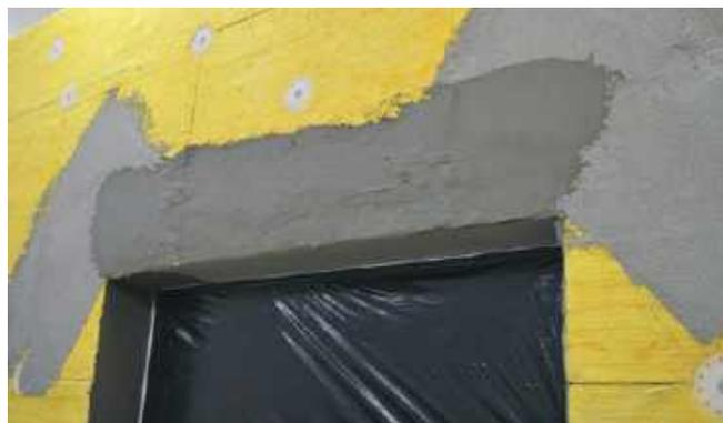
На откос и внешнюю часть теплоизоляции наносится армировочно-клеевая смесь толщиной 1,5–2 мм.
