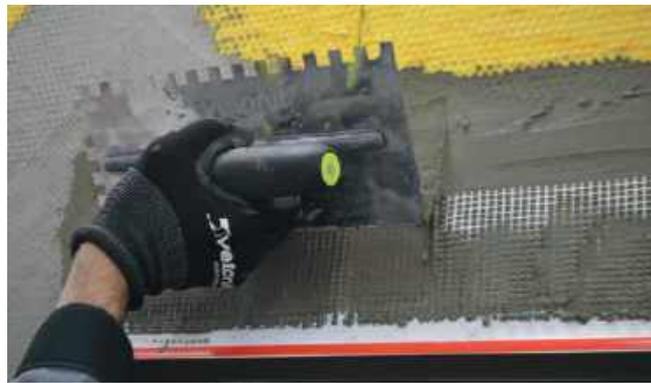
**Примечание.** При монтаже элемента внешнего угла с капельником капельник должен оставаться видимым. Использовать капельник в качестве маяка для ведения кельмы запрещено.
