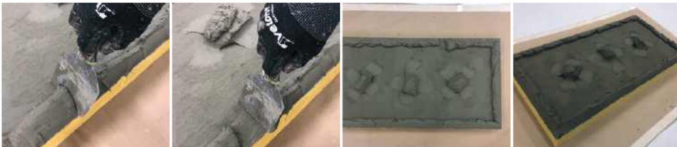
2. Высота и ширина клеевого бортика зависят от отклонений на конкретном объекте, на конкретном основании.
