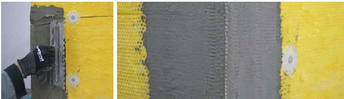
Элементы внешнего угла должны устанавливаться встык по отношению друг к другу с нахлестом сетки одного элемента на другой. Нахлест сетки одного элемента на другой должен составлять не менее 100 мм. Для реализации этого правила от пластикового сердечника элемента внешнего угла отрывается сетка минимум на 100 мм и производится удаление пластикового сердечника.
