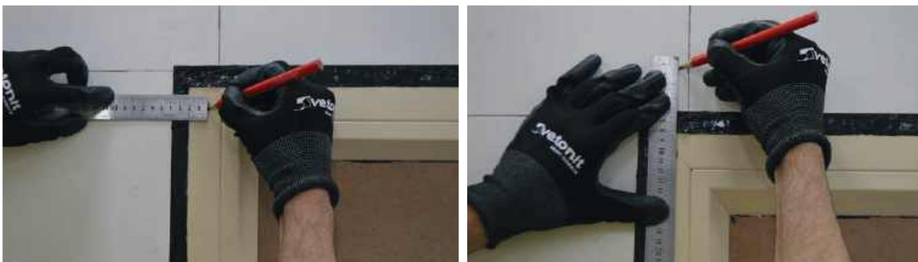
**Примечание.** Минимальное заведение теплоизоляции на блок оконного/дверного проема должно составлять 20 мм. На нижнюю часть рамы плиты теплоизоляции не заводятся.
