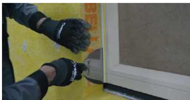
Перед дальнейшим формированием внешних откосов проема раму рекомендуется защитить при помощи пленки. Для этого со съемной планки элемента примыкания удаляется антиадгезионная желтая лента.
