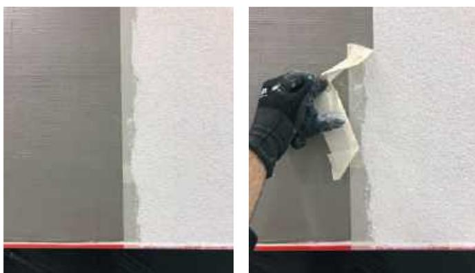
**Примечание.** Дальнейшее нанесение декоративной штукатурки на следующие захватки производится после высыхания ранее нанесенной декоративной штукатурки.
