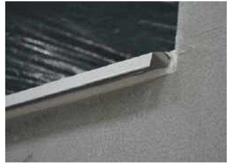
После установки, перед нанесением защитно-декоративного слоя, отлив должен быть защищен при помощи защитной пленки или других средств защиты.
