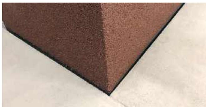
Декоративная штукатурка наносится при помощи металлической кельмы в 1,5–2 зерна на небольшой фрагмент базового штукатурного слоя.
