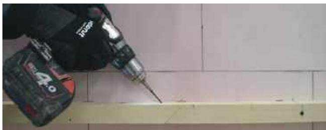
Первый крепеж элемента опорного бруса в районе внешнего угла здания рекомендуется устанавливать с отступом от линии внешнего угла здания на 100 мм.
