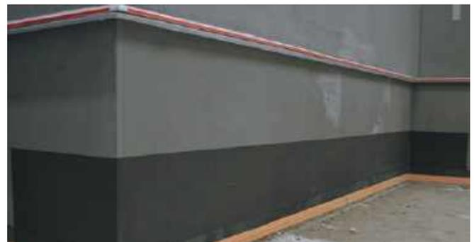
На место примыкания СФТК в цокольной части здания и нижней кромки СФТК на основной плоскости фасада наносится герметик.
