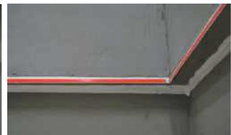
**Примечание.** Для создания ровной линии герметика и исключения попадания герметика на поверхность базового штукатурного слоя по линии СФТК в цокольной части здания и СФТК на основной плоскости фасада рекомендуется приклеить малярную ленту.
