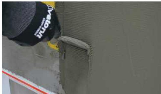
При дальнейшем производстве работ армировочно-клеевая смесь наносится на ранее подготовленный стык рулонов стеклосетки и на необходимый участок теплоизоляции.
