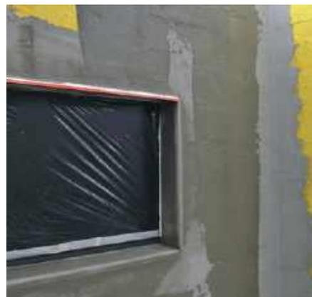
На подготовленную поверхность наносится армировочно-клеевая смесь толщиной 5–6 мм.
