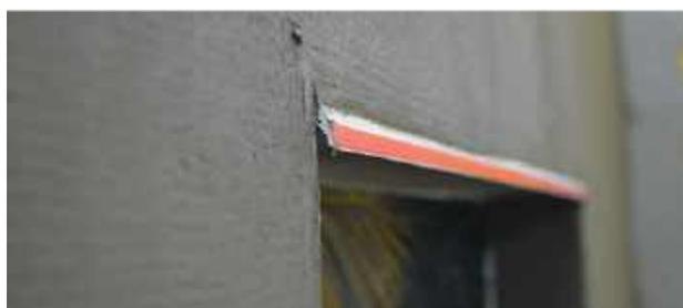
В районе внешних/внутренних углов СФТК край полотна армирующей стеклосетки не доводится до линии угла на 20–25 мм.
