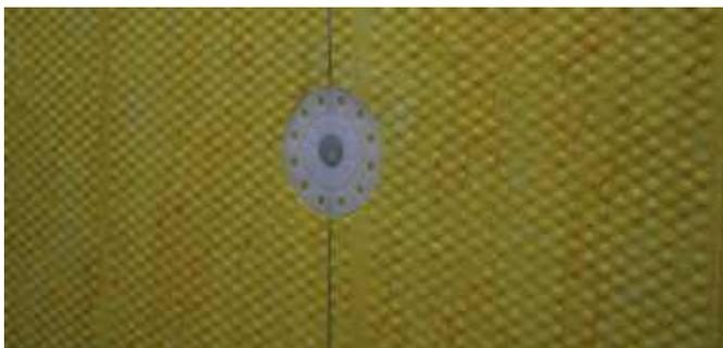
**Примечание.** При использовании тарельчатого анкера с завинчивающимся распорным элементом финальная фиксация тарельчатого анкера производится при помощи шуруповерта.
