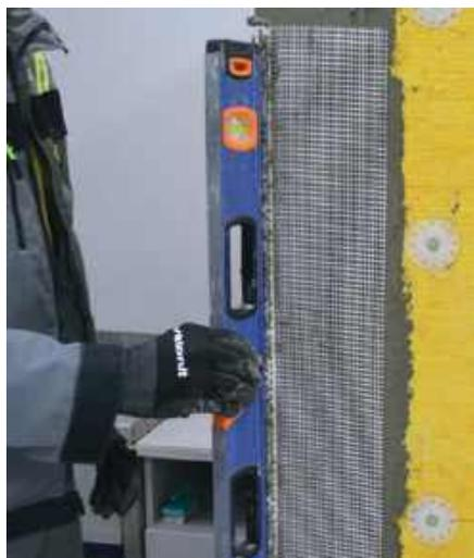
**Примечание.** Ровность установки элементов внешнего угла контролируется при помощи уровня.
