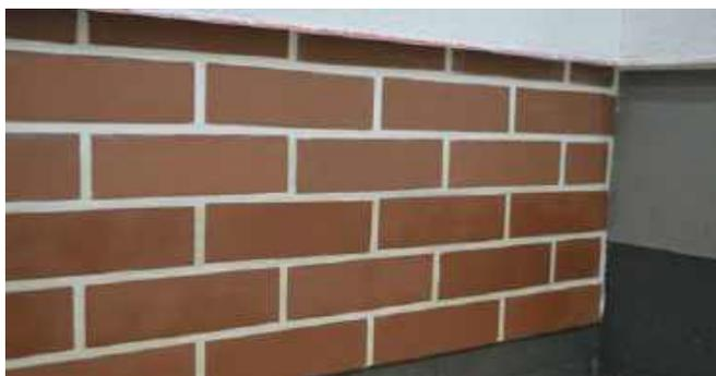
**ВНИМАНИЕ!** Поверхность, обработанная гидрофобизирующим составом, может отличаться по цвету от необработанной поверхности. Перед применением гидрофобизирующего состава рекомендуется пробно нанести его на оставшиеся обрезки плиток и убедиться, что обработанная поверхность соответствует цветовым ожиданиям.
