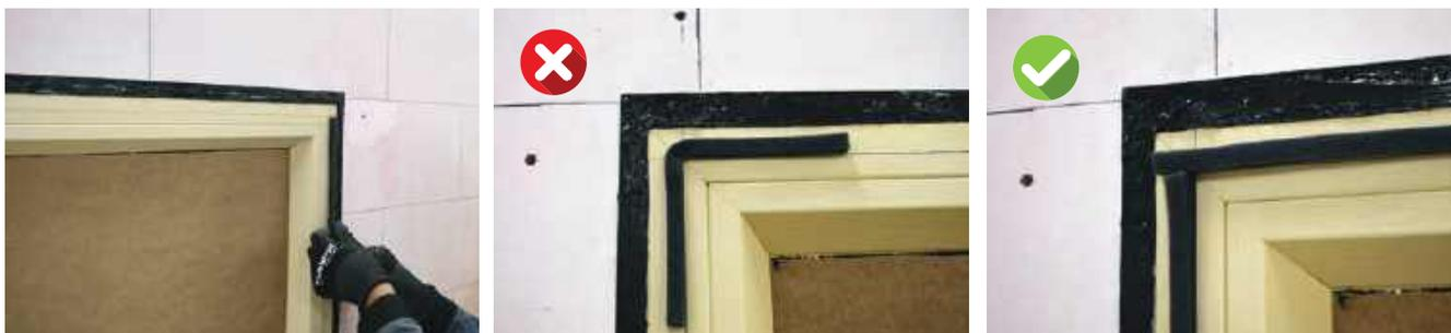
На углах проема утеплитель монтируется из цельного фрагмента теплоизоляции с необходимым раскроем плиты теплоизоляции по линиям проема так, чтобы стыки швов с примыкающими плитами находились на расстоянии не менее 150 мм от угла проема.
