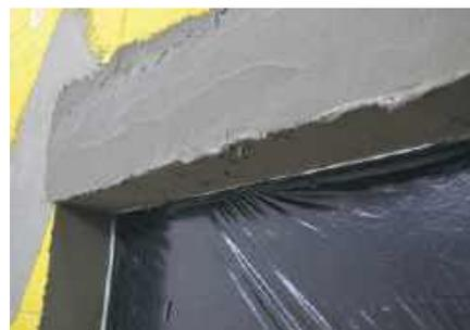
На подготовленный верхний откос устанавливается элемент внешнего угла с капельником.
