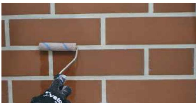
**Примечание.** При обработке поверхности гидрофобизирующим составом на отдельном участке состав рекомендуется наносить через малярную ленту.
