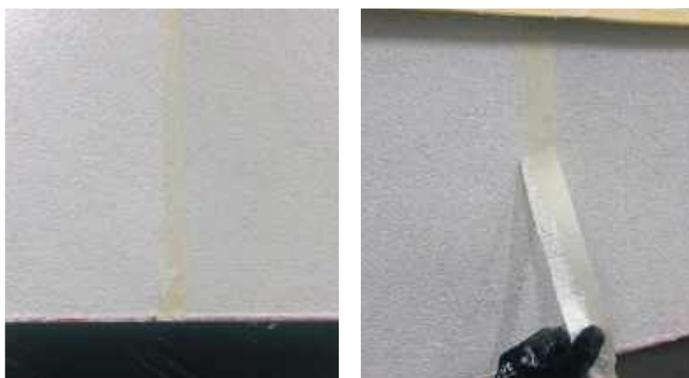
**Примечание.** При нанесении декоративной штукатурки необходимо следить за тем, чтобы затирка на всех участках поверхности фасада производилась в одном направлении.
