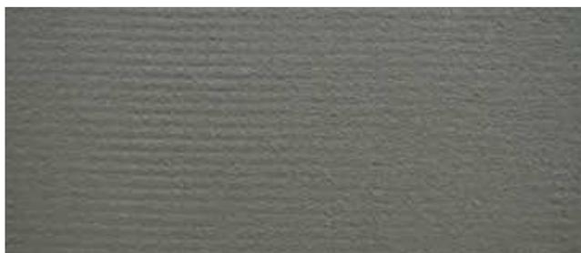
При таком способе создания базового штукатурного слоя будет четко просматриваться структура армирующей стеклосетки. Данный визуальный эффект гарантирует правильное расположение стеклосетки в толще базового штукатурного слоя.
