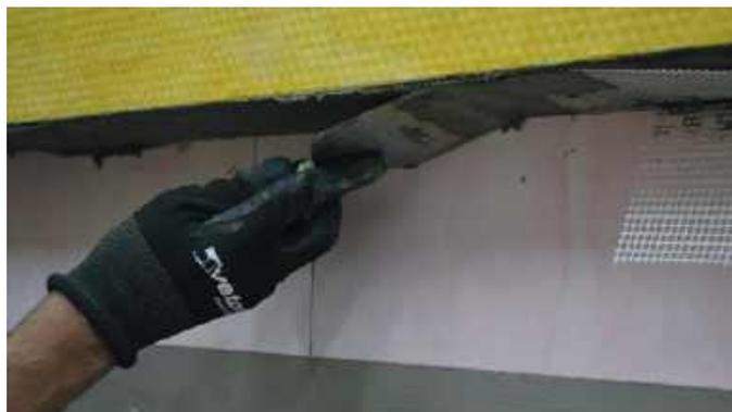
Перед установкой элемента внешнего угла с капельником лицевую поверхность СФТК необходимо прогрунтовать при помощи армировочно-клеевой смеси на сдир. Грунтовка лицевой поверхности СФТК производится на ширину сетки элемента внешнего угла с капельником.
