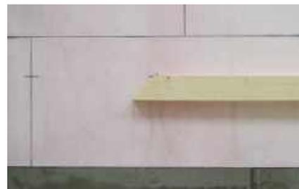
**Примечание.** При наличии деформационных швов в строительном основании опорный брус на участке деформационного шва прерывается на ширину этого деформационного шва.
