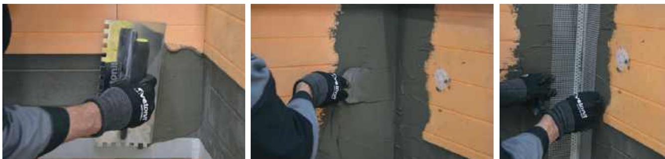
Производится установка подготовленного элемента внутреннего угла / бандажной полосы.
