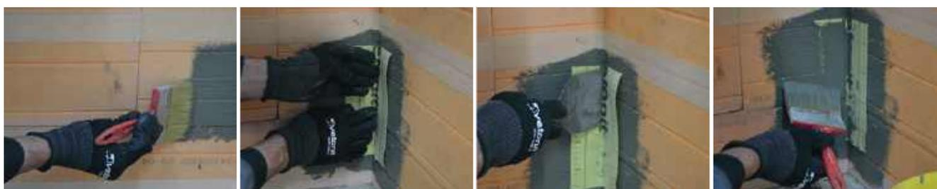
Аналогичные технологические операции производятся на внешнем углу здания.
