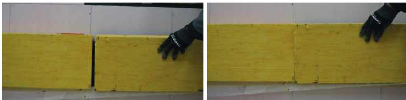
Криволинейность лицевой поверхности плит теплоизоляции контролируется при помощи шнуры и двухметрового правила.
