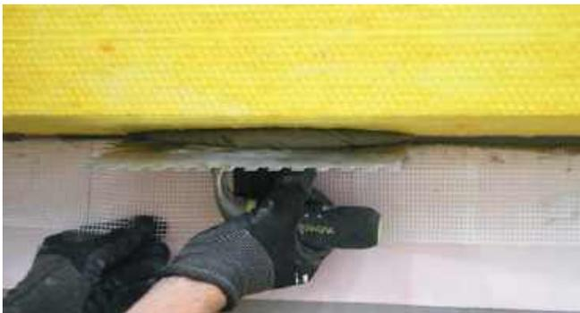
На подготовленную нижнюю грань плит теплоизоляции наносится армировочно-клеевая смесь толщиной 1,5–2 мм.
