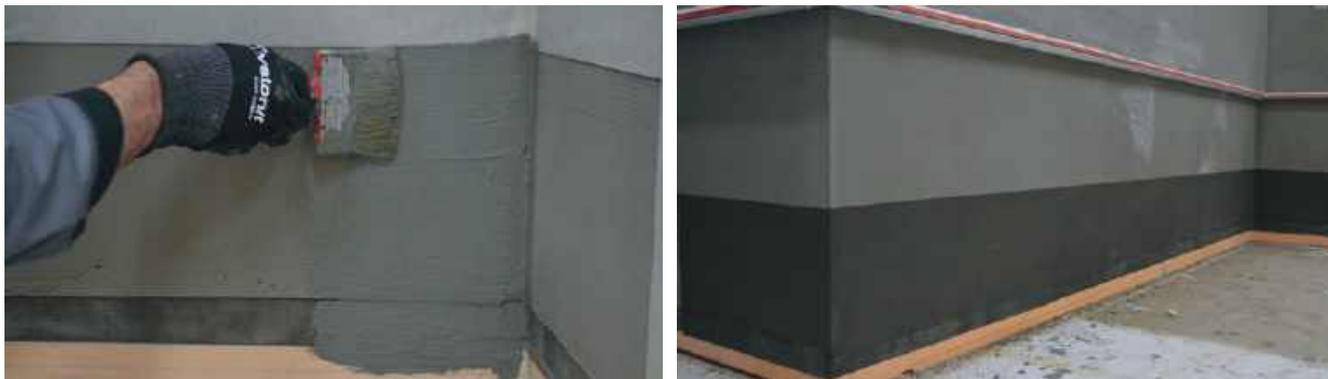
На место примыкания СФТК в цокольной части здания и нижней кромки СФТК на основной плоскости фасада наносится герметик.
