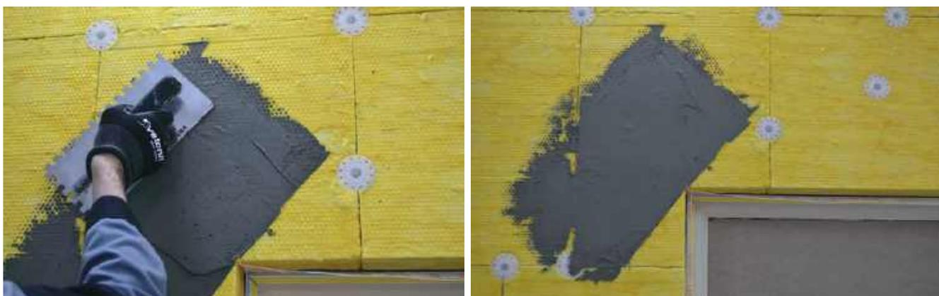
Усиливающая косынка устанавливается на углу пересечения линий горизонтального и вертикального откосов.
