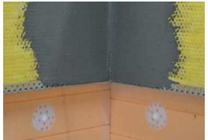
Элементы внутреннего угла должны устанавливаться встык по отношению друг к другу с нахлестом сетки одного элемента на другой. Ширина нахлеста сеток должна составлять не менее 100 мм.
