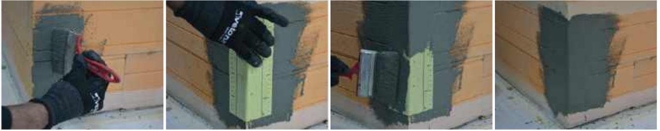
Состав наносится на 150–200 мм ниже и на 50–100 мм выше нулевой отметки отмостки.
