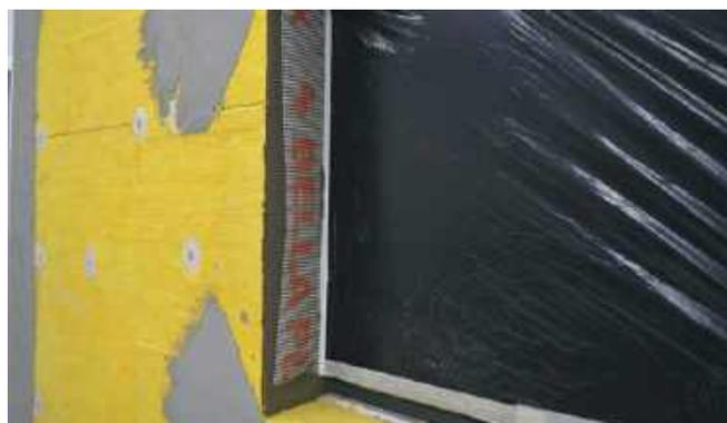
На подготовленные поверхности теплоизоляции наносится армировочно-клеевая смесь толщиной 1,5–2 мм.
