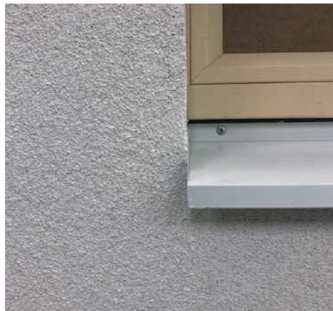
По периметру отлива также наносится герметик.
