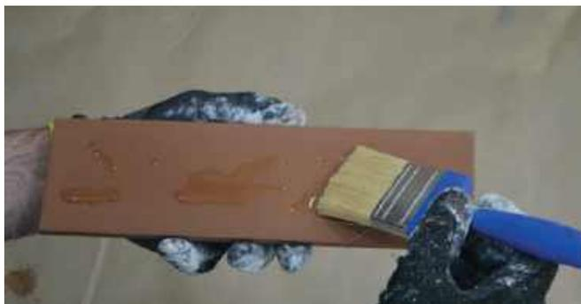
Гидрофобизатор наносится вручную (при помощи кистей, валиков) и механизированным способом (безвоздушными аппаратами, а также садовыми опрыскивателями).
