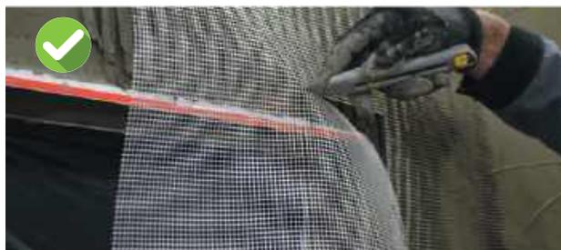
Для полного исключения возможности повреждения ранее установленных усиливающих элементов проема лезвие ножа рекомендуется повернуть на себя, отвернув от плоскости фасада.
