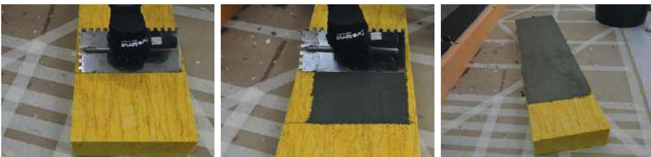
Производится нанесение клеевой/армировочно-клеевой смеси по периметру плиты теплоизоляции.
