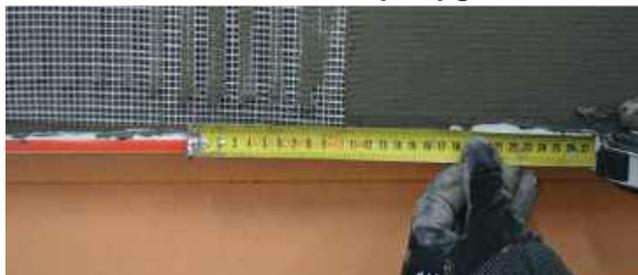
При устройстве базового штукатурного слоя образуются продольные (вертикальные) и торцевые (горизонтальные) стыки полотен армирующей стеклосетки.
