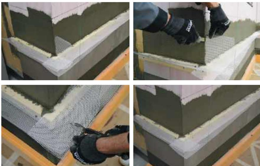
Производится удаление лишнего фрагмента бандажной полосы, образовавшегося при вертикальном срезе бандажной полосы.
