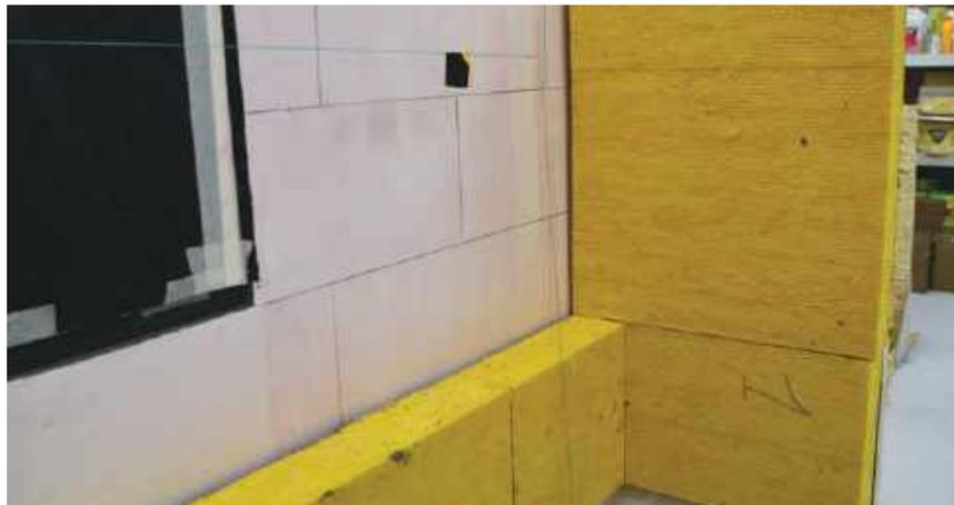
На внешних углах здания плиты теплоизоляции устанавливаются с выносом за границы примыкающей стены.
