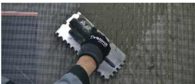
Полотно стеклосетки приглаживается гладкой стороной шпателя/кельмы до момента, когда армировочно-клеевая смесь начнет проступать через ячейки стеклосетки.
