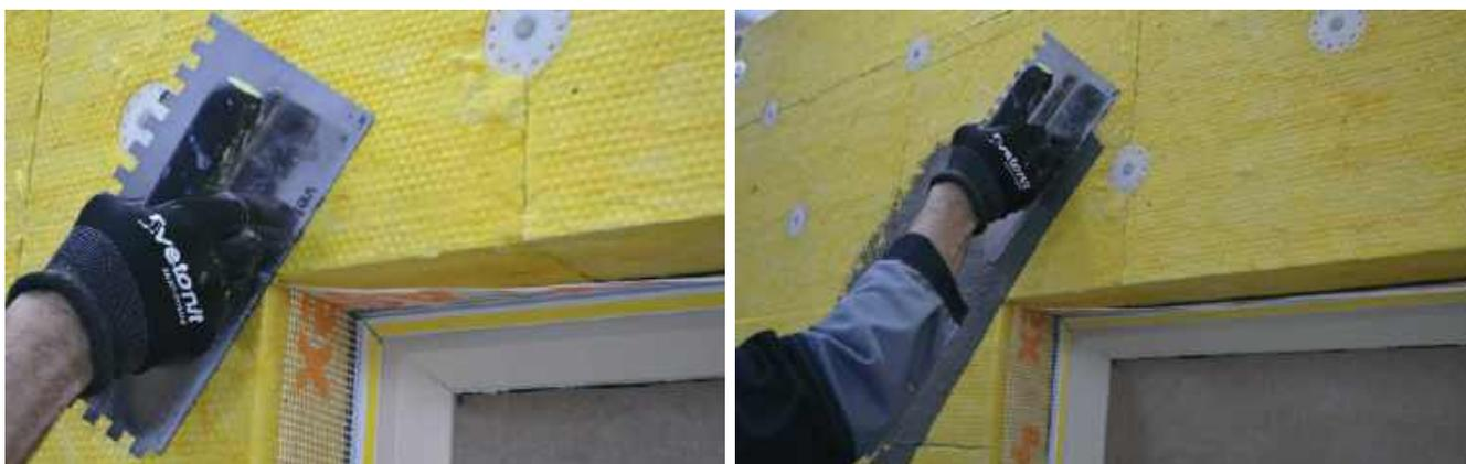
На подготовленный прогрунтованный участок теплоизоляции наносится армировочно-клеевая смесь толщиной 1,5–2 мм.
