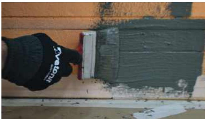
Внутренние и внешние углы рекомендуется выполнять с использованием гидроизоляционных лент.
