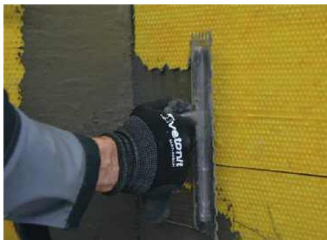
Производится установка подготовленного элемента внутреннего угла / бандажной полосы.
