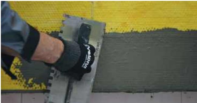
На нижнюю грань плит теплоизоляции повторно наносится армировочно-клеевая смесь толщиной 1,5–2 мм.
