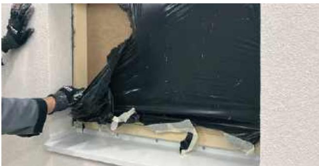
По периметру проемов удаляются съемные планки с элемента примыкания.
