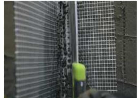
Армирующая сетка элемента внутреннего угла / бандажная полоса приглаживается к ранее нанесенной армировочно-клеевой смеси и утапливается в нее.
