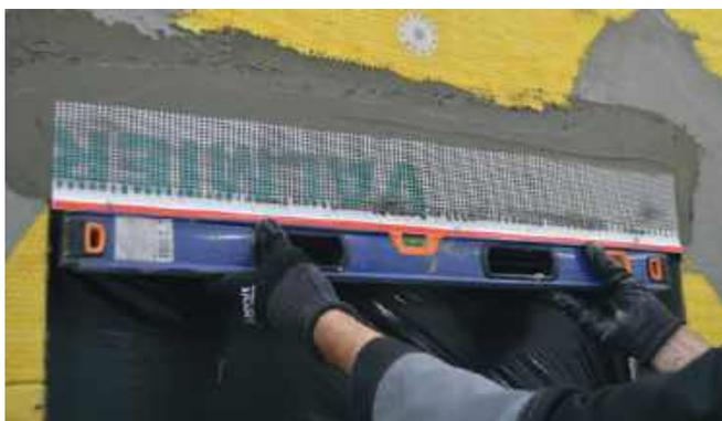
На поверхность откоса наносится армировочно-клеевая смесь методом шпаклевания толщиной 1–1,5 мм. С поверхности фасада производится удаление излишков армировочно-клеевой смеси методом «на сдир».
