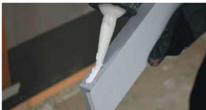
Отлив устанавливается в проектное положение и плотно прижимается к подоконному профилю и нижнему откосу.
