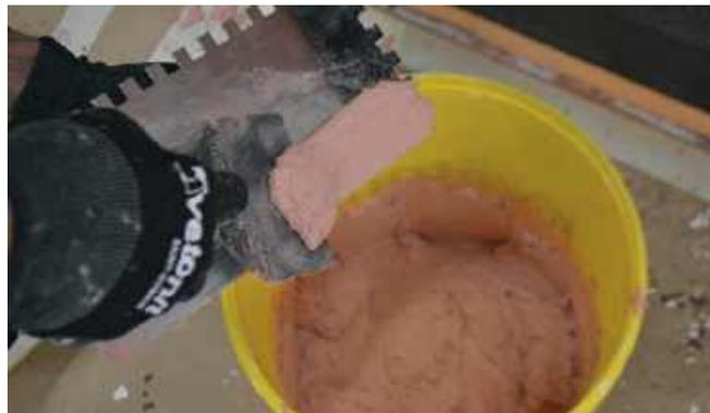
Декоративная фактура создается методом затираания поверхности с помощью пластиковой гладилки (терки) сразу после нанесения декоративной штукатурки, не дожидаясь заветривания поверхности. Излишки связующего, образующиеся на рабочей поверхности пластиковой терки, периодически удаляются.
