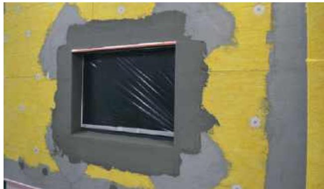
**Примечание.** При финальном формировании внешних откосов оконного/дверного проема элемент примыкания **не заполняется** армировочно-клеевой смесью полностью.
