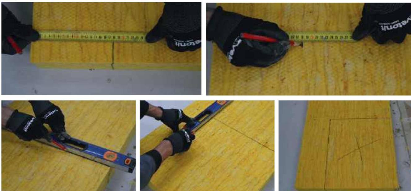
**Примечание.** Для формирования уклона внешнего оконного отлива в нижней части оконного проема плиты теплоизоляции рекомендуется резать под углом. Рекомендуемый уклон внешнего оконного отлива должен составлять не менее 10–15 градусов. Данный уклон в градусах соответствует отношению величины уклона к толщине теплоизоляции.
