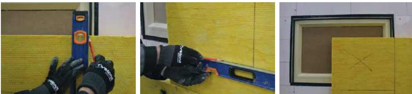
Производится перенос линий откоса на тыльную (внутреннюю) сторону теплоизоляции.
