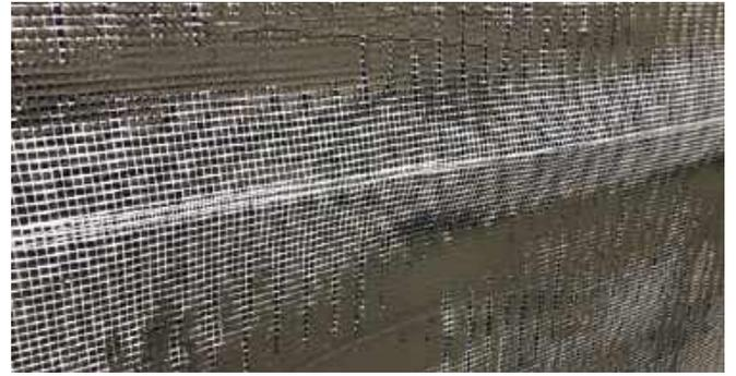
Перед установкой бандажной полосы место разреза отчищается от армировочно-клеевой смеси методом «на сдир».
