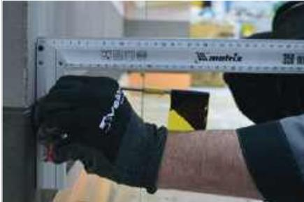
Производится фиксация расстояния от основания до нижней шнурки.
