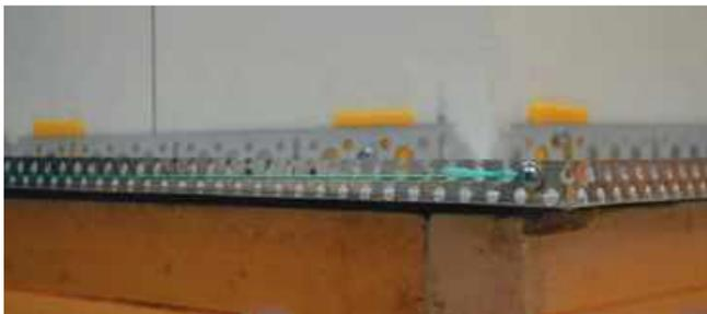
Цокольный профиль должен отстоять от основания на проектную толщину клеевого слоя. Для этого при установке цокольного профиля в проектное положение между цокольным профилем и строительным основанием помещают дистанционные прокладки.
