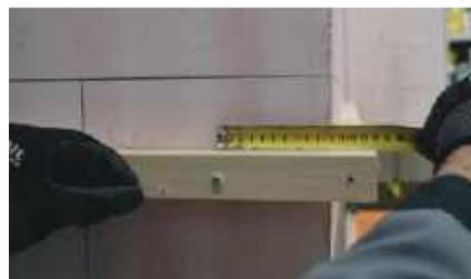
**Примечание.** В местах стыковки опорного бруса на основной плоскости фасада, а также на внутренних и внешних углах верхняя грань бруса должна идти в одну линию, без ступенек.
