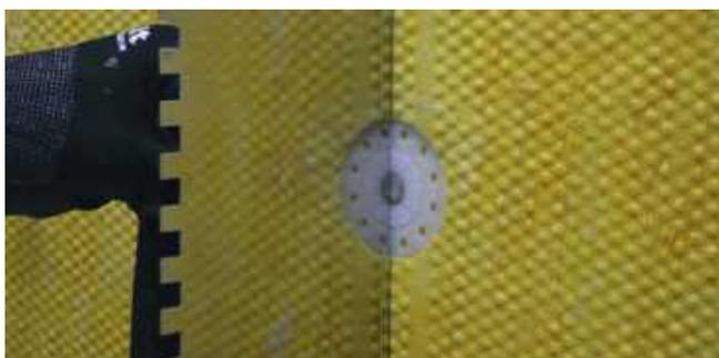
После установки тарельчатого анкера тарелка анкера не должна выступать за внешнюю (лицевую) поверхность теплоизоляции.
