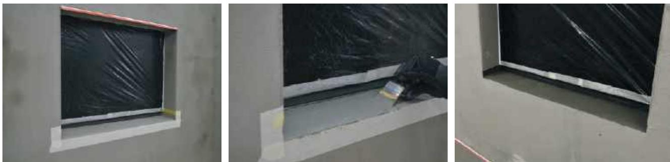
Для изготовления отлива производится замер фактической ширины проема.
