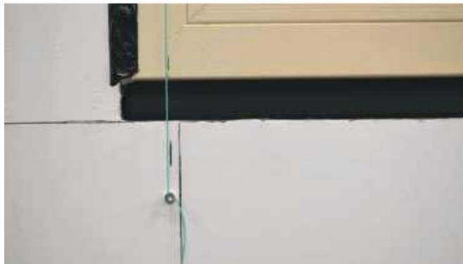
Производится перенос линии шнура на поверхность блока оконных проемов на всех этажах.
