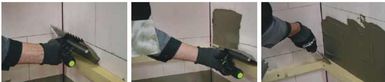
Нанесенная смесь дозируется при помощи зубчатой кельмы с размером зуба 10 × 10 / 12 × 12 мм.
