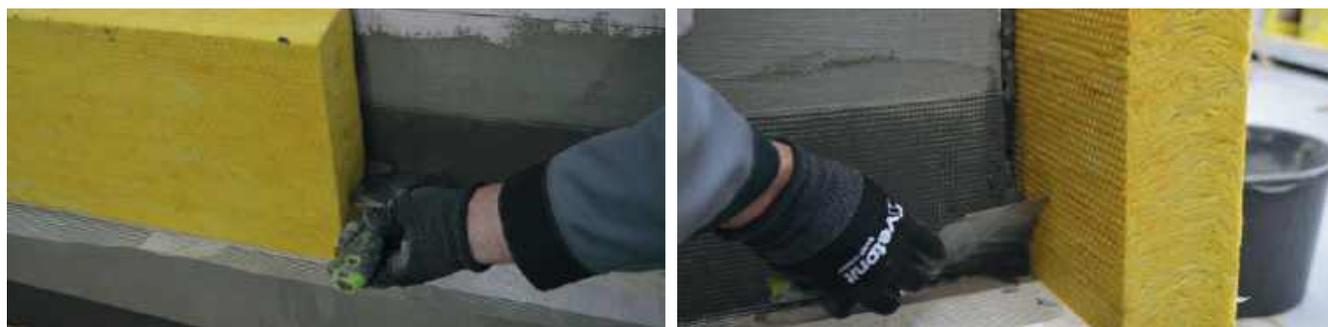
Вертикальное и горизонтальное расположение плиты теплоизоляции контролируется при помощи уровня и шнуры.
