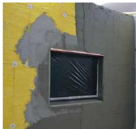
Армировочно-клеевая смесь дозируется при помощи зубчатой кельмы. Излишки армировочно-клеевой смеси возвращаются в строительную емкость.
