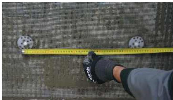
Тарельчатые анкеры устанавливаются в край полотна стеклосетки, середину полотна, а также в стык двух полотен стеклосетки.
