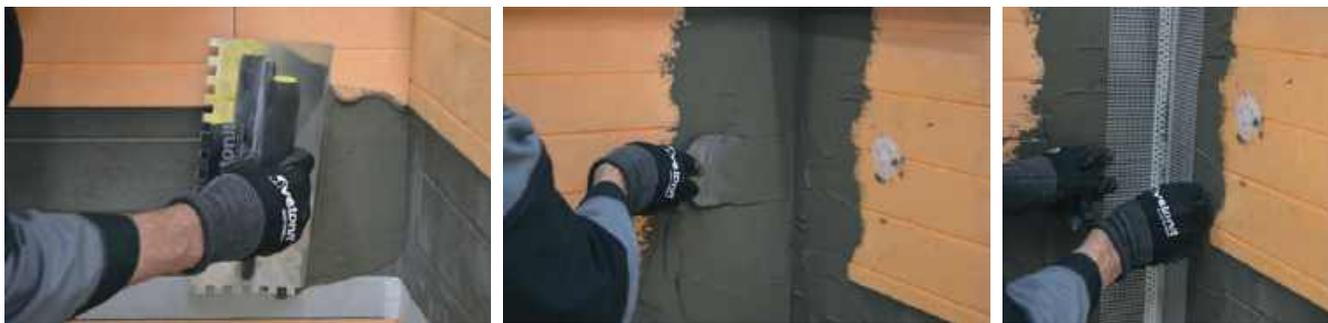
На подготовленный участок внутреннего угла устанавливается элемент внутреннего угла.
