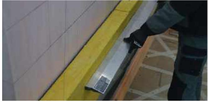
Производится монтаж плит теплоизоляции с прилегающих поверхностей внешнего/внутреннего углов. Плиты теплоизоляции устанавливаются в проектное положение с плотным примыканием друг к другу. Вид внешнего и внутреннего углов при монтаже СФТК через опорный брус.
