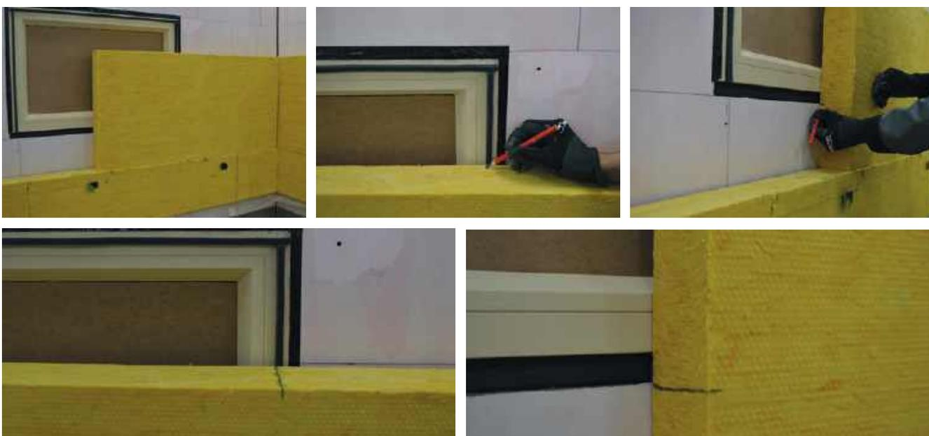
Производится перенос линий откоса на лицевую поверхность теплоизоляции.
