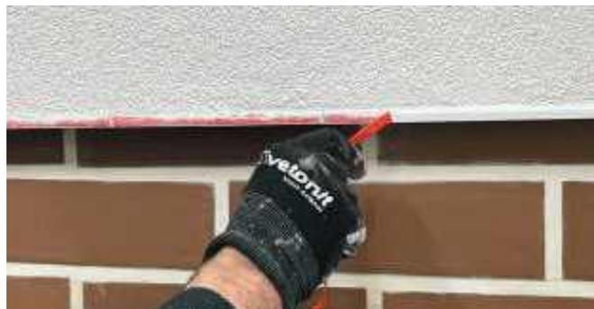
Удаляются защитные пленки с внешних отливов и проемов.
