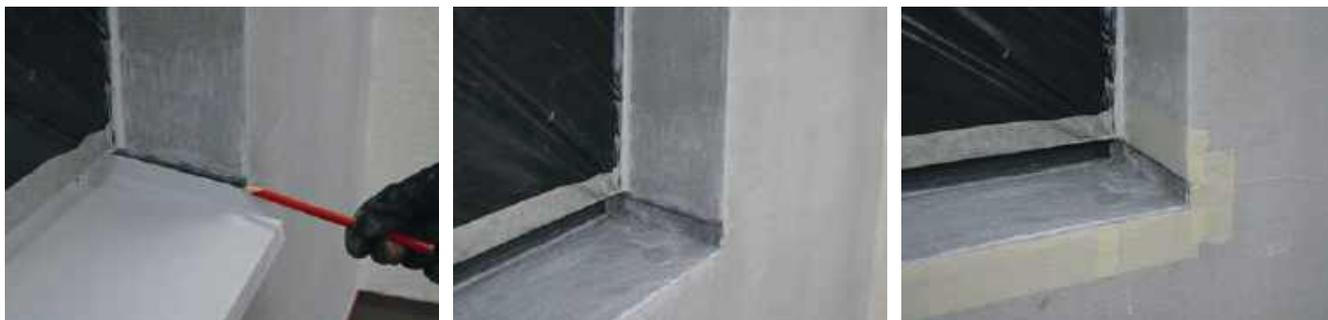
На боковые откосы, вдоль откоса по внутренней и внешней его частям и на основную плоскость откоса наносится герметик.
