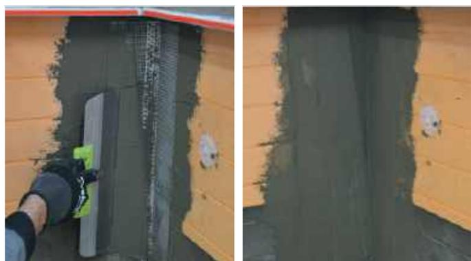
Производится установка элемента внешнего угла на внешний угол цокольной части здания. Предварительно на поверхность утеплителя наносится армировочно-клеевая смесь толщиной 2–3 мм.
