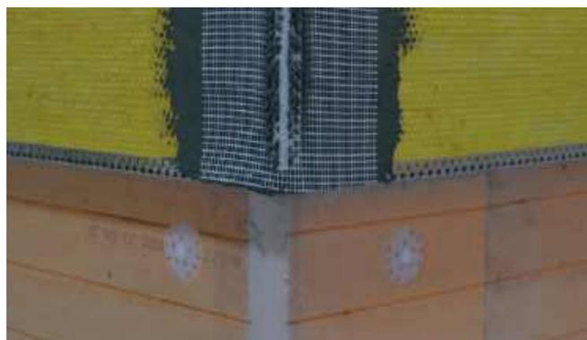
Армирующая сетка элемента внешнего угла приглаживается к ранее нанесенной армировочно-клеевой смеси и утапливается в нее.
