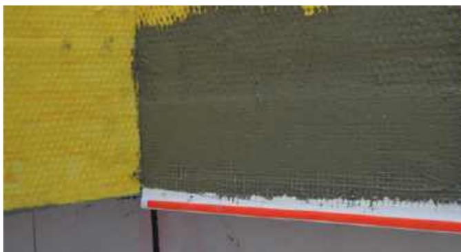
Элементы внешнего угла с капельником должны устанавливаться встык по отношению друг к другу с нахлестом сетки одного элемента на другой. Нахлест сетки одного элемента на другой должен составлять не менее 100 мм.
