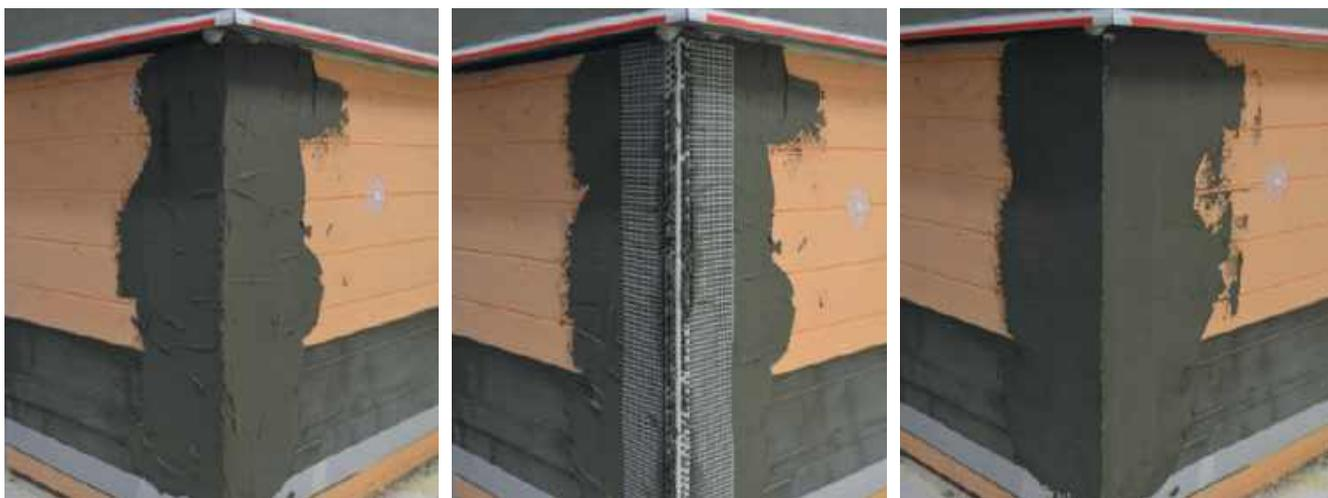
**Примечание.** При установке элемента внешнего угла через перфорацию пластикового сердечника элемента должна выступать армировочно-клеевая смесь.
