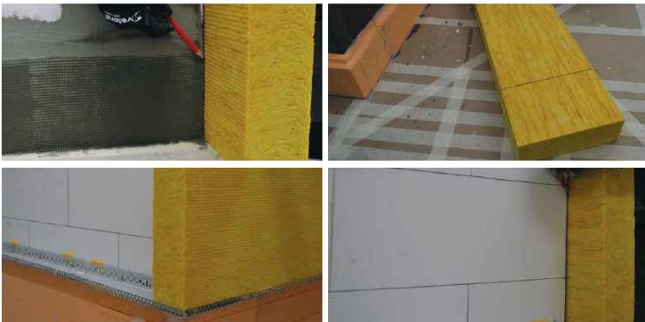
Производится грунтование плиты теплоизоляции от линии разметки.
