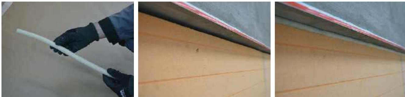
Для утепления цокольной части здания применяется экструзионный пенополистерол с максимальной суммарной толщиной 150 мм и фактической средней плотностью от 23 до 33 кг/м<sup>3</sup> или фасадный пенополистерол (гранулированный суспензионный) с максимальной суммарной толщиной 200 мм марки не ниже ППС15Ф, ППС16Ф, ППС20Ф (для классов надежности СФТК по применению СК1 и СК0) и ППС13Ф (для классов надежности СФТК по применению СК2).
