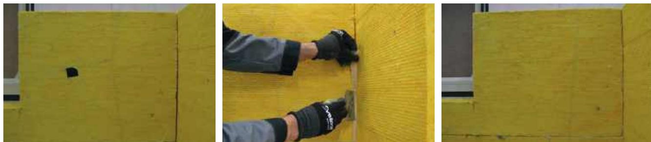
При использовании ППС/ХПС зазоры допускается заполнять при помощи монтажного клея-пены.
