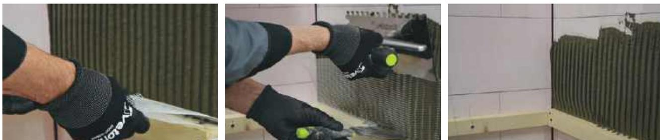
Производится вдавливание бандажной полосы с удалением излишков клеевой/армировочно-клеевой смеси методом «на сдир».
