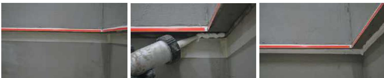
**Примечание.** Для создания ровной линии герметика и исключения попадания герметика на поверхность базового штукатурного слоя по линии стыка цокольной части здания и нижней кромки СФТК рекомендуется приклеить малярную ленту.
