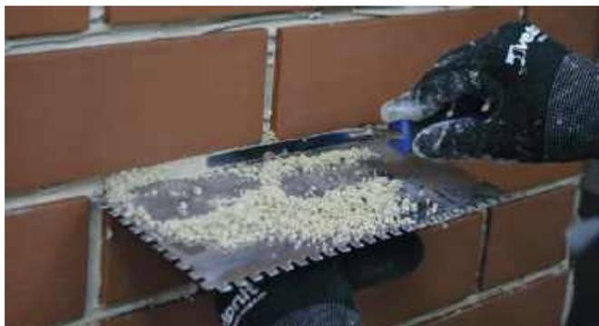
**ВНИМАНИЕ!** Свежий шов не должен подвергаться атмосферным осадкам, а также дальнейшей обработке (например, нанесению гидрофобизирующего состава) в течение 72 часов.
