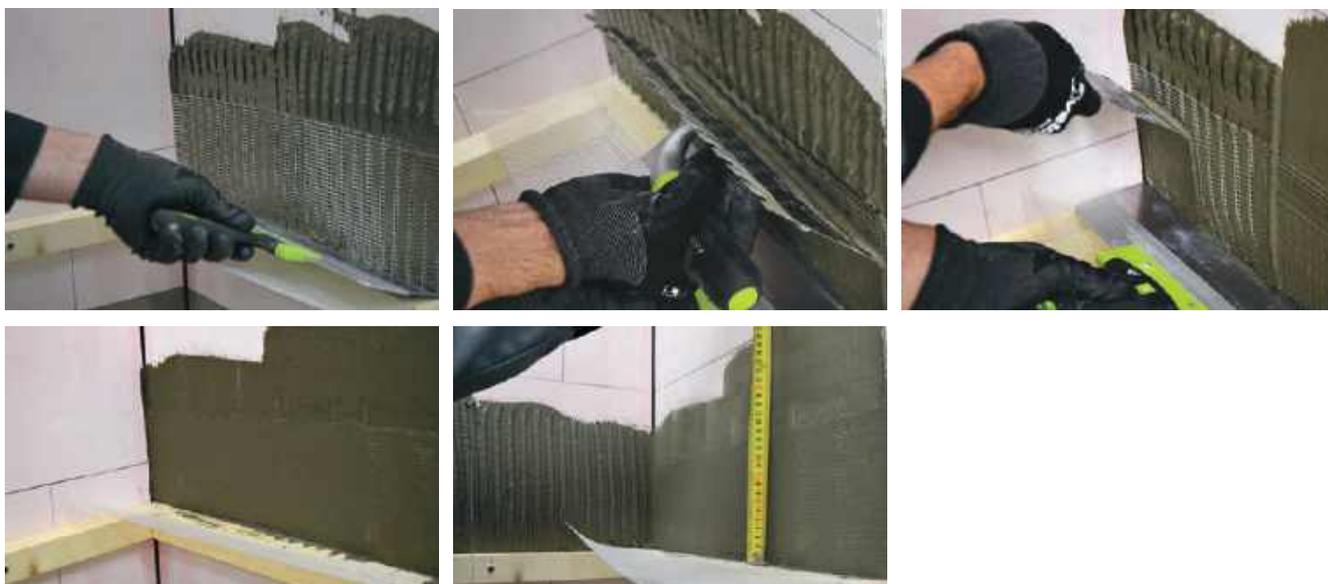
Полотна бандажной полосы укладываются внахлест. Ширина нахлеста бандажных полос должна составлять не менее 100 мм.
