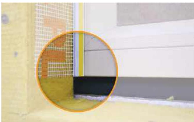
**Примечание.** Для дополнительной фиксации элементов примыкания к раме допускается дополнительное придавливание элемента примыкания при помощи шпателя. Шпатель должен идти по внутренней полости элемента примыкания.
