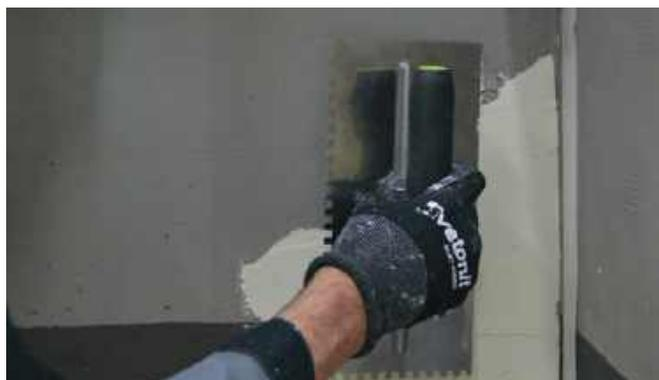
**Примечание.** Для уменьшения вероятности заветривания клеевого состава на поверхности базового штукатурного слоя его рекомендуется наносить малыми захватками на 2–3 ряда по высоте и на 3–5 плиток в длину.
