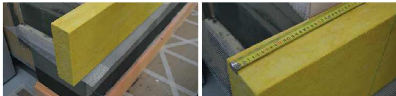
С обратной стороны фиксируется граница вылета плиты теплоизоляции за линию внешнего угла.
