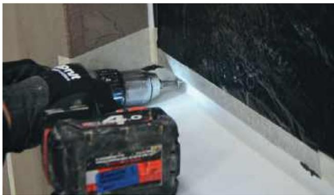
**Примечание.** Между боковой щечкой отлива и боковым откосом должен оставаться зазор шириной 1,5–2,5 мм.
