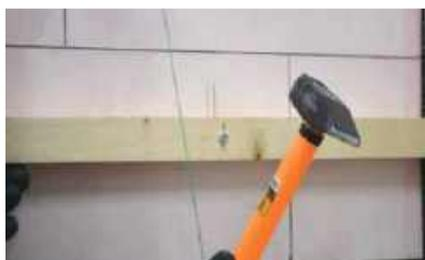
Место стыка двух элементов опорного бруса соединяется при помощи самореза.
